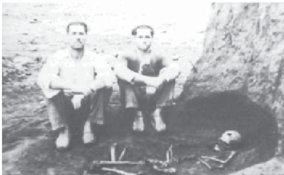
Excavació a la Bòbila a la dècada dels 40
